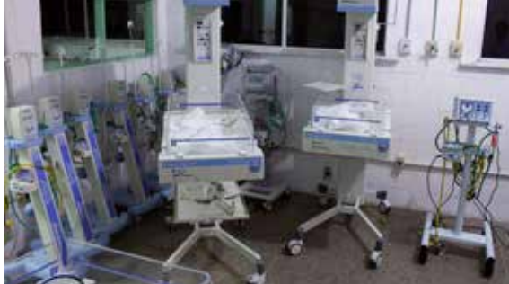
Equipamentos sem uso, por falta de adequação estrutural, flagrados pelo Cremeb
